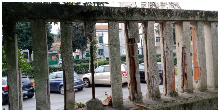
Recinzioni lato sud-via Zola
