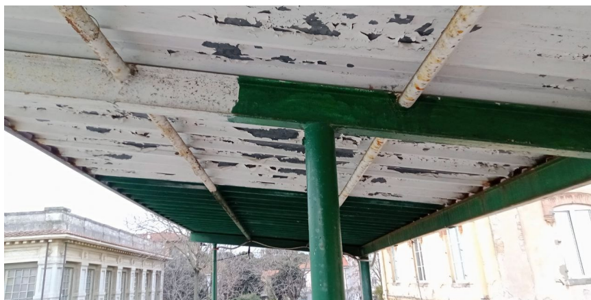
Tettoia in lamiera del palco
