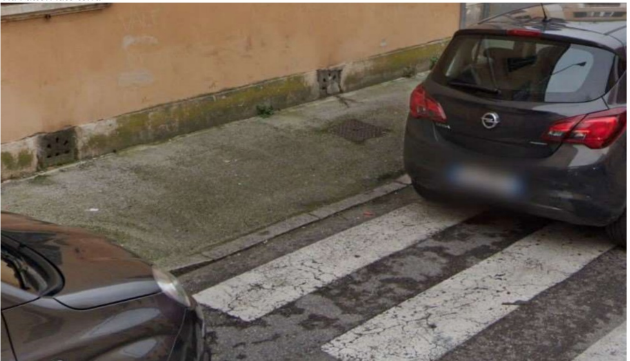
lato terra – marciapiede sud
